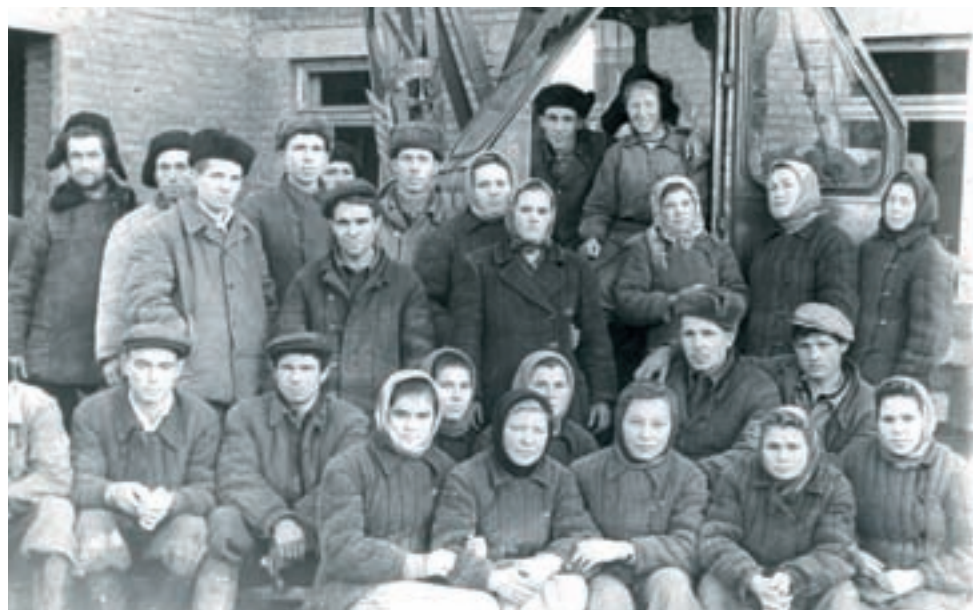
30 ОКТЯБРЯ 1962 ГОДА. БРИГАДА НИКОЛАЯ МИХАЙЛОВА НА СТРОИТЕЛЬСТВЕ ПОЛИКЛИНИКИ ХИМКОМБИНАТА. ВАЛЕНТИНА ШВЕРЛО В КАБИНЕ КРАНА (справа). ФОТО ИЗ ДОМАШНЕГО АРХИВА В.ШВЕРЛО.
